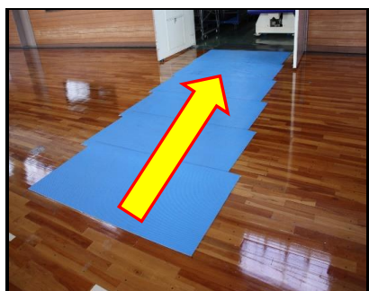
④（戻し）養生シートを敷いてください。重ね部分向きが逆になるのでご注意ください。
